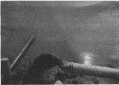
FIGURA 1 - Descarga da lama na barragem
