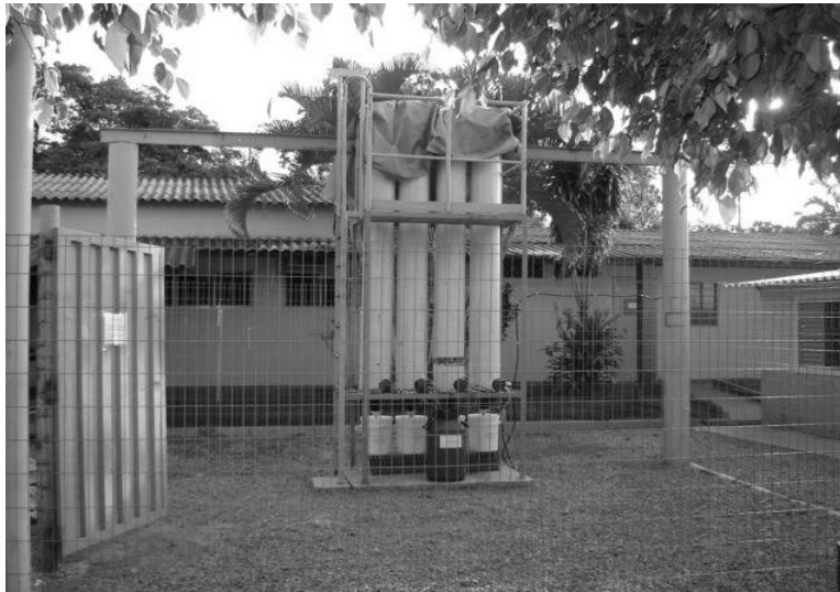
Figura 1 – Colunas de Lixiviação em Pilha
