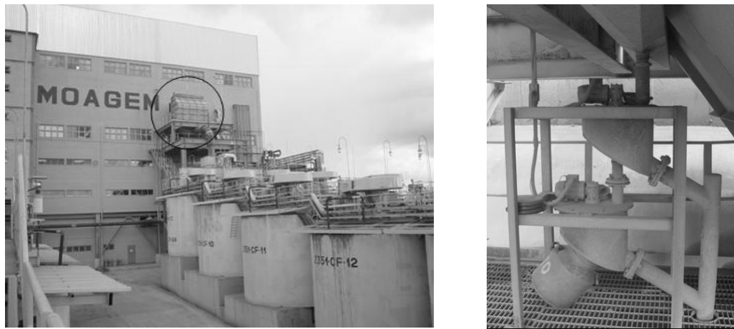
Figura 2 – Sistema de amostragem da flotação do Sossego (a esquerda) e detalhe dos quarteadores rotativos (direita)
