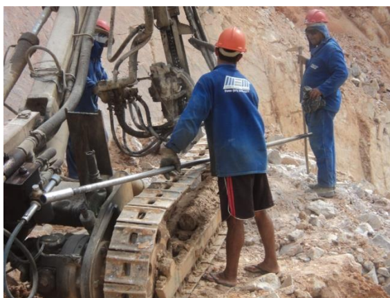
Figura 2. Perfuração e preparação para desmonte secundário (Fogacho).
